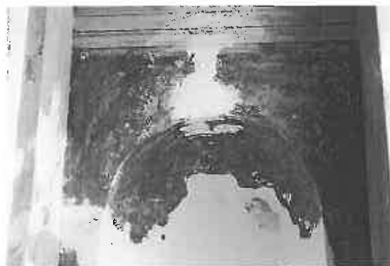
Una delle nicchie della Loggia dopo la pulitura e la stuccatura delle lacune.
