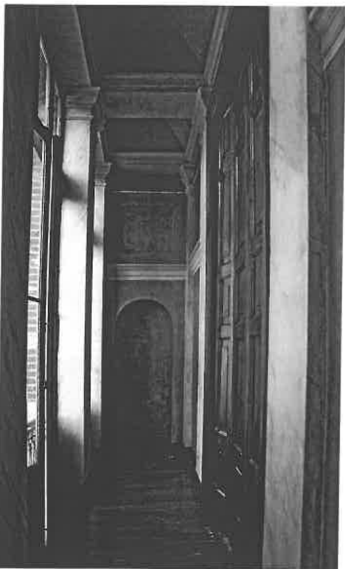
L'interno della Loggia al termine dei lavori di restauro.
