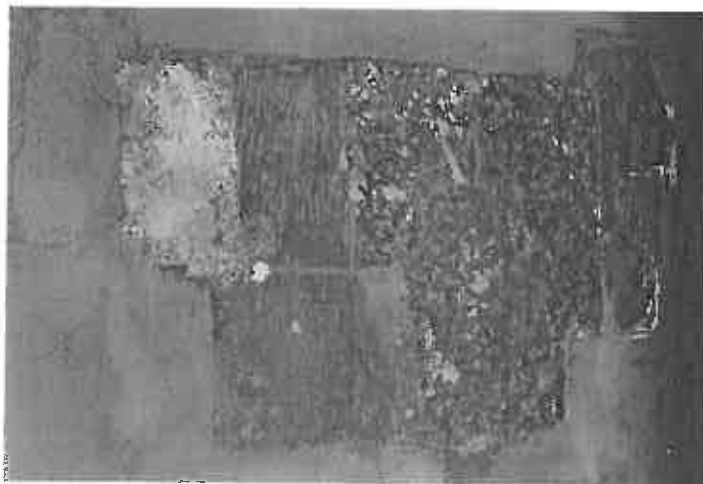
Tasselli stratigrafici sulle pareti della Loggia.
